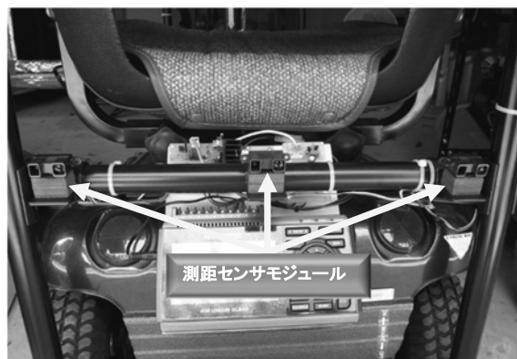
Fig.7 後方センサの取り付け状況
